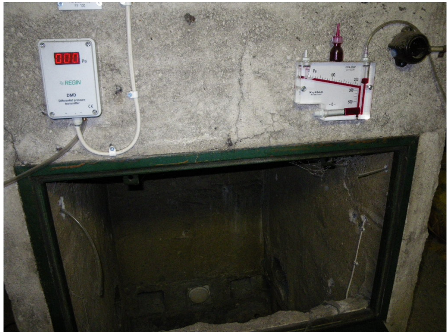
Lucköppning till fläkt och sugkammare
