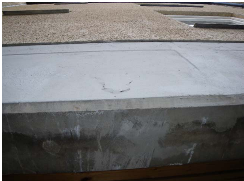
Spricka framkant balk
