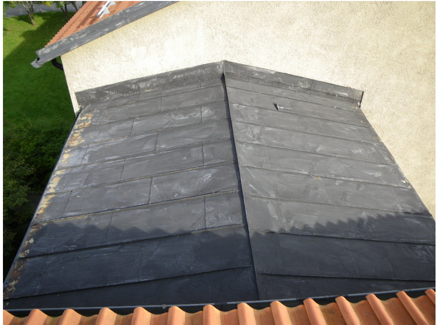
Låglutande tak med skivtäckning
