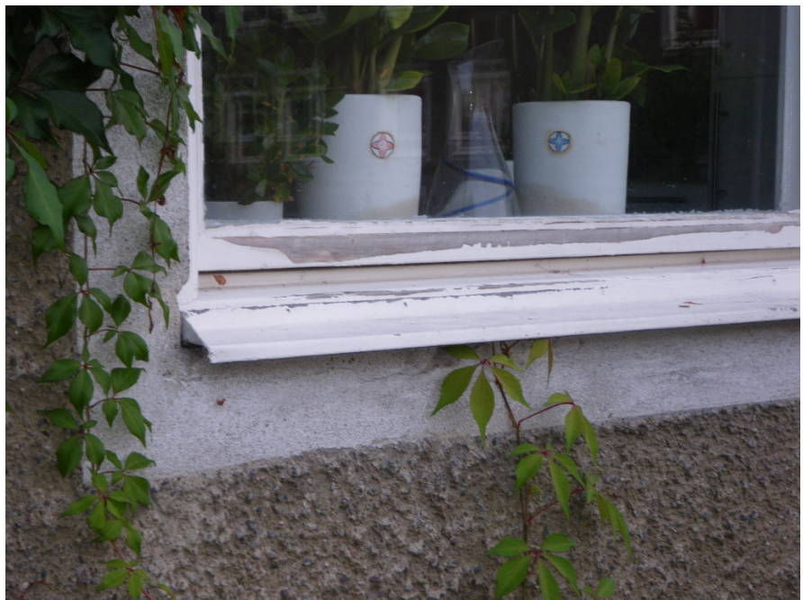
Fönster med flagad färg.
