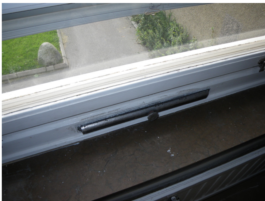
Fönster med uteluftsventil i karmunderstycke
