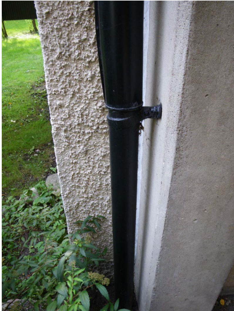
Stuprör vid portal
