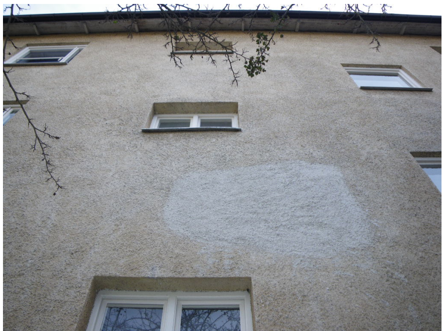
Putslagning med avvikande färg
