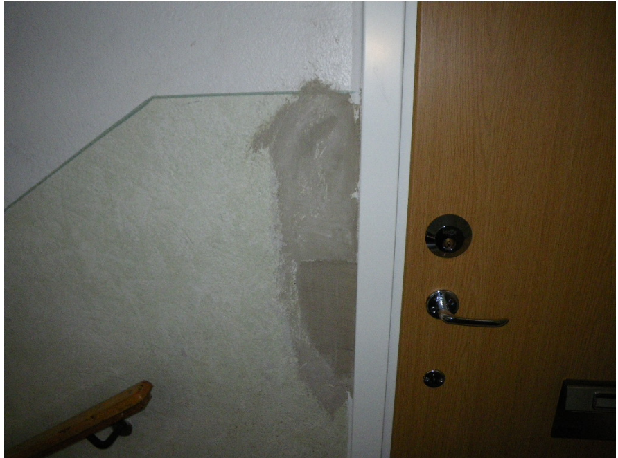
Port 70, skada efter dörrbyte
