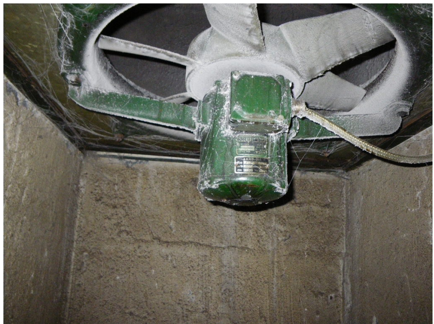
Frånluftsfläkt (från byggåret)
